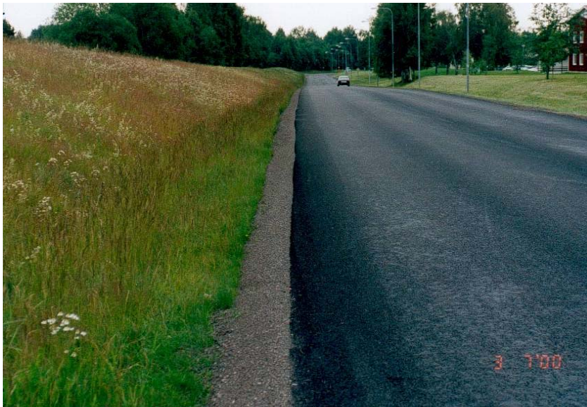
Bild 12-5 Asfaltgranulat som stödremsa.
