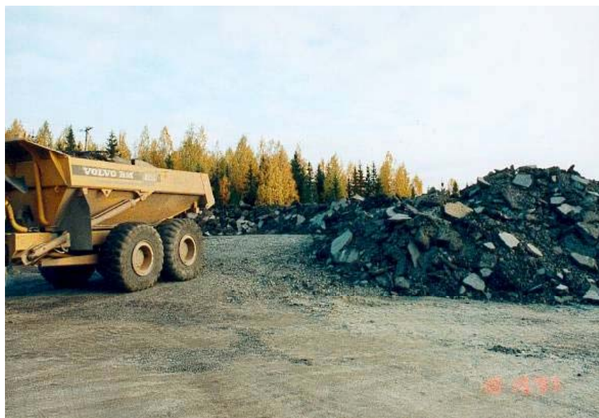
Bild 12-1 Uppgrävd asfalt i upplag.
