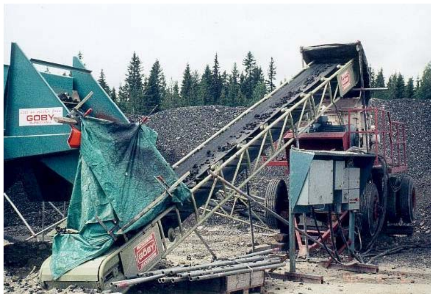
Bild 12-2 Krossning och sortering av retur-asfalt.
