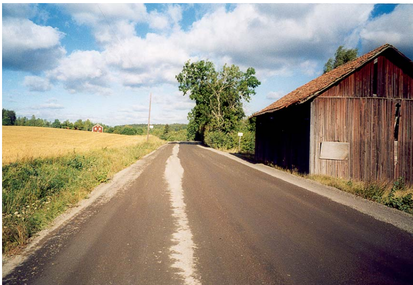
Bild 10-8 Vägytan efter fräsning och packning.
