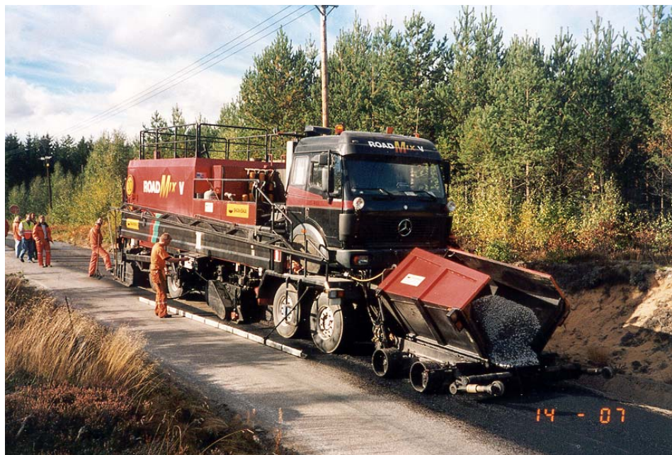
Bild 10-6 Halvvarm återvinning av befintlig beläggning genom inblandning av bindemedel och makadam. Även ny massa kan inblandas. Innan fräsningen uppvärms ytan med hjälp av Heating.
