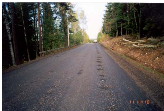
Bild 10-9 Slaghål på relativt nylagd kallstabiliserad yta. Innan beläggningen lades lagades slaghålen (vänster). Instabil yta på grund av högt fuktinnehåll och mycket finmaterial (höger).
