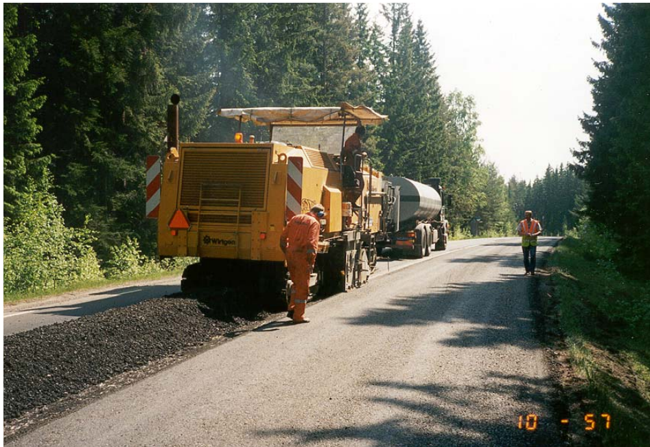
Bild 10-3 Kall återvinning (kall remixing) av befintlig beläggning genom infräsning av bitumenemulsion. I detta fall inblandas ca 2,0 % emulsion i befintlig beläggning.
