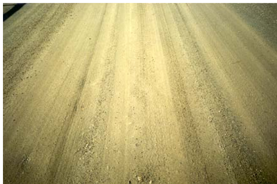
Bild 10-9 Slaghål på relativt nylagd kallstabiliserad yta. Innan beläggningen lades lagades slaghålen (vänster). Instabil yta på grund av högt fuktinnehåll och mycket finmaterial (höger).
