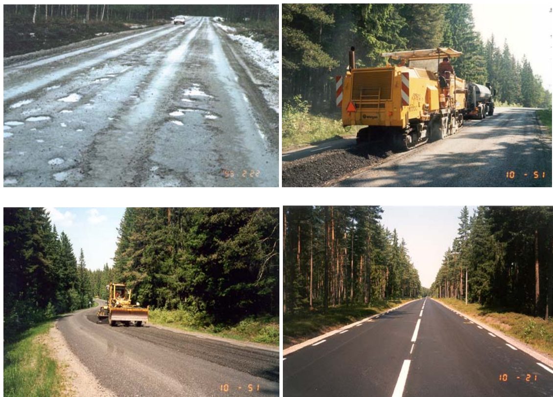
Bild 10-10 Vägbanan innan åtgärd (övre vänster). Inblandning av bindemedel med djupfräs (över höger). Justering av det stabiliserade materialet (nedre vänster). Färdig väg efter det slitlagret lagts (nedre höger).
