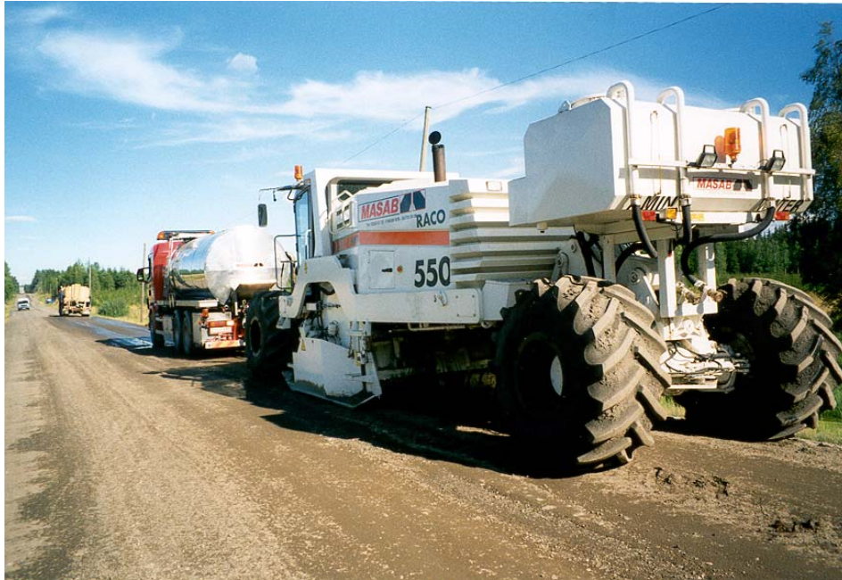
Bild 10-4 Djupfräs för kall återvinning och stabilisering. Både emulsion och skummat bitumen kan inblandas med den här typen av maskiner. Innan bindemedel tillsätts brukar materialen homogeniseras genom torrfräsning.
