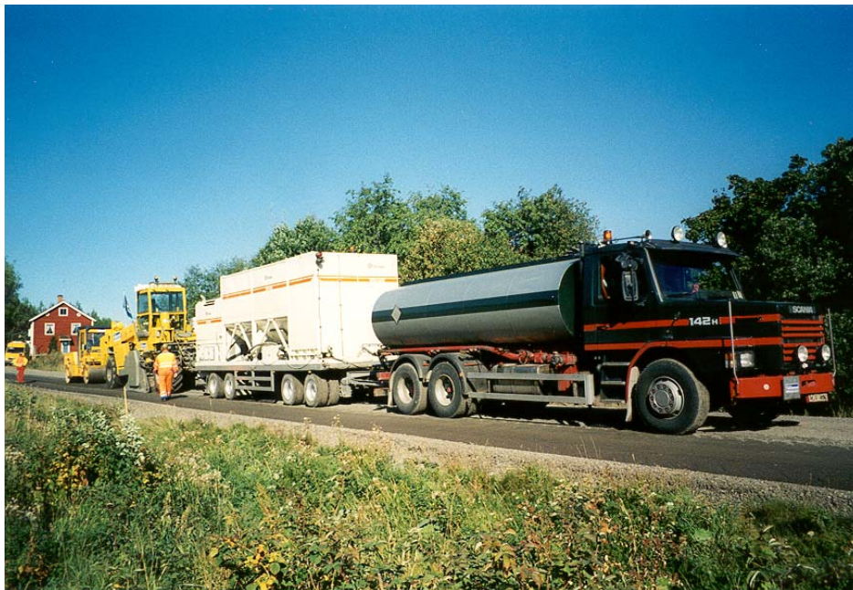
Bild 10-5 Kall återvinning (kall remixing) av befintlig beläggning genom infräsning av bitumenemulsion (3 %) och tillsats av en mindre mängd cement (1-2 %). Cementen förbättrar framför allt materialets resistens mot vatten och styrar samtidigt upp lagret.
