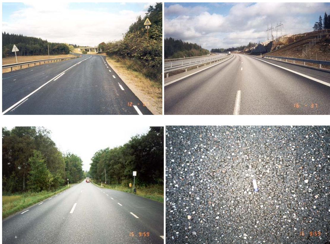
Bild 9-8 Övre vänster: Provsträckor med varm återvinningsbeläggning vid Stäket utanför Stockholm (1996). I detta försök testades inblandning av 15 % granulat i ABS 16 och 25 % i ABT 16. Övre höger: Trafikerat bindlager med 20-40 % granulatinblandning. Nedre vänster och höger: ABS 11 med 20-40 % granulat av kvartsitmassor.
