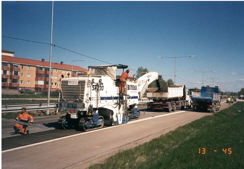
Bild 9-4 Kallfräsning (planfräsning) av asfaltbeläggning. Oftast tas bara det översta (20-40 mm) lagret bort vid planfräsning.
