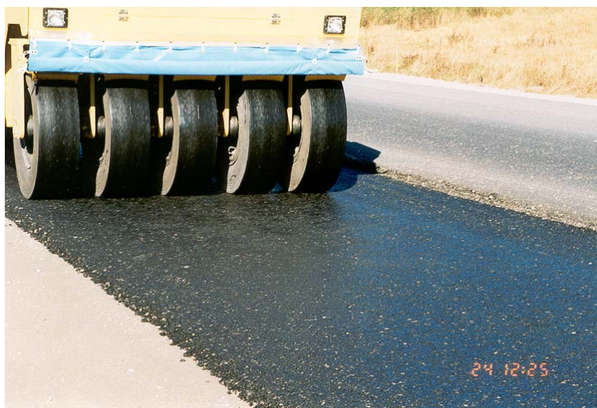
Bild 8-7 Gummihjulsvältning av halvvarm återvinningsmassa. Ytan blir på så sätt tätare och hårdare.
