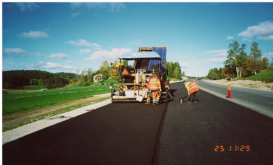
Bild 8-6 Utläggning av halvvarma återvinningsmassor som bärlager. Massorna kom ursprungligen från gamla E4 vid Höga Kusten.
