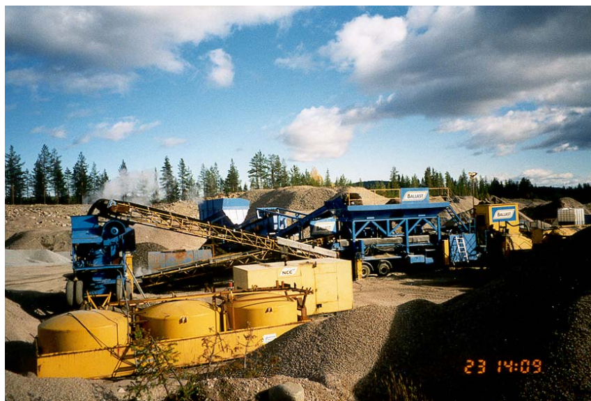
Bild 8-3 Tillverkning av halvvarma massor i kontinuerligt blandningsverk. Granulat och stenmaterial uppvärms måttligt i torktrumman till vänster i bilden. Det uppvärmda materialet transporteras sedan till blandaren där mjukbitumen tillsätts.
