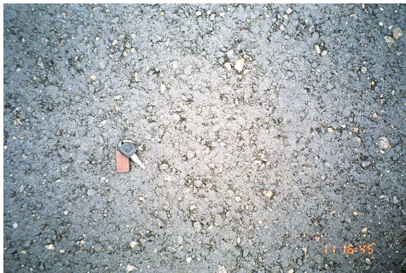
Bild 8-8 Nylagd yta av halvvarm återvinningsmassa som bärlager.
