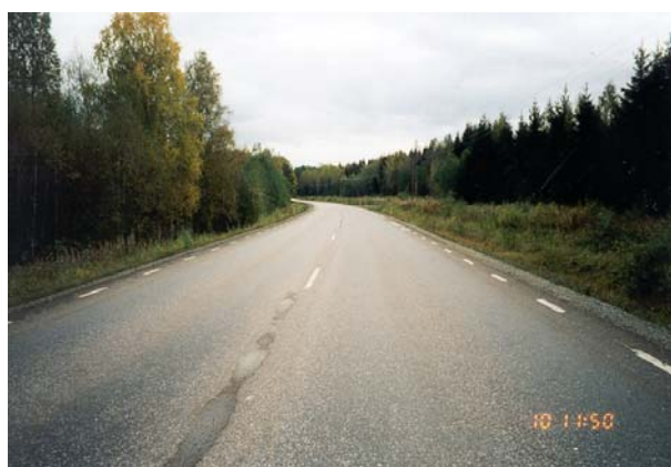
Bild 7-16 Provsträckor på riksväg 63, Saxån, efter 7 års trafik. Både bär- och slitlagren utgjordes av kall återvinningsbeläggning.
