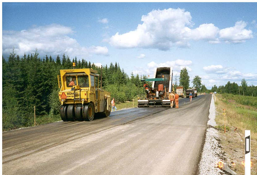
Bild 7-7 Utläggning och packning av kallt återvunnet asfaltbärlager. I detta fall användes en kombinerad stålvals- och gummihjulsvält.
