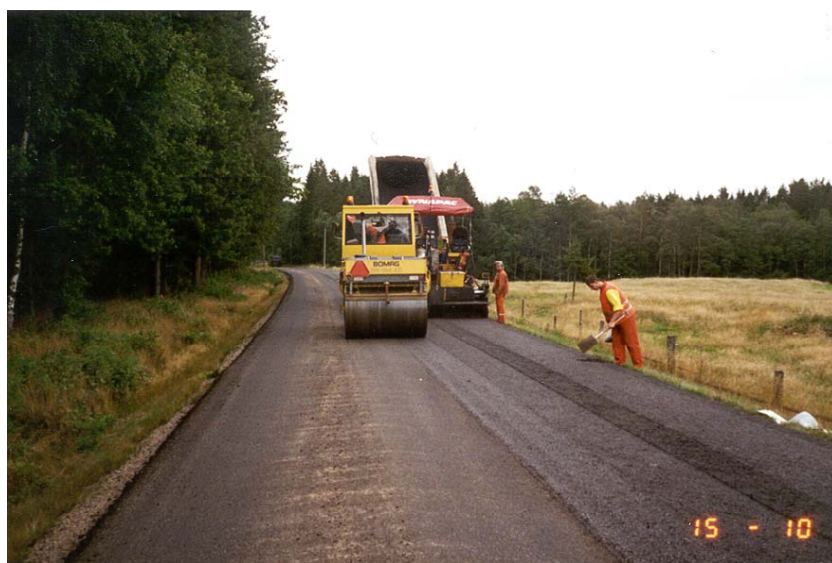
Bild 7-8 Utläggning och packning av kallt återvunnet asfaltslitlager.
