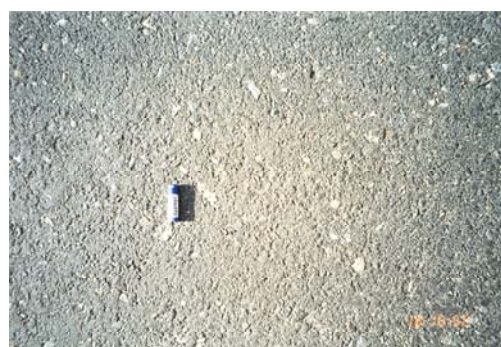
Bild 7-9 Nylagd kallt återvunnen beläggning (övre vänster). Mekaniska skador på nylagd yta (övre höger). Kallt återvunnen beläggning efter ett års trafik (nedre vänster). Närbild på kallt återvunnen beläggning efter ett års trafik (nedre höger).
