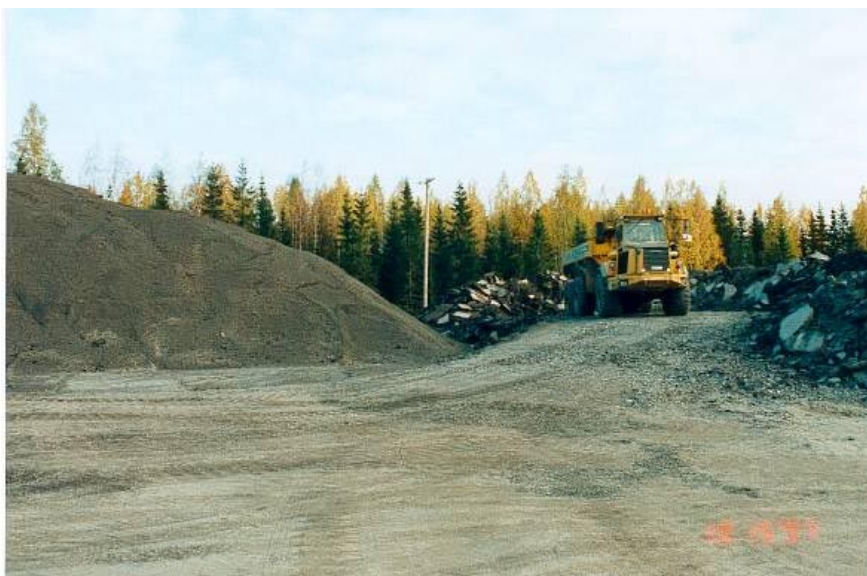
Bild 3-2 Mellanlager med såväl uppgrävd som granulerad returafalt.
